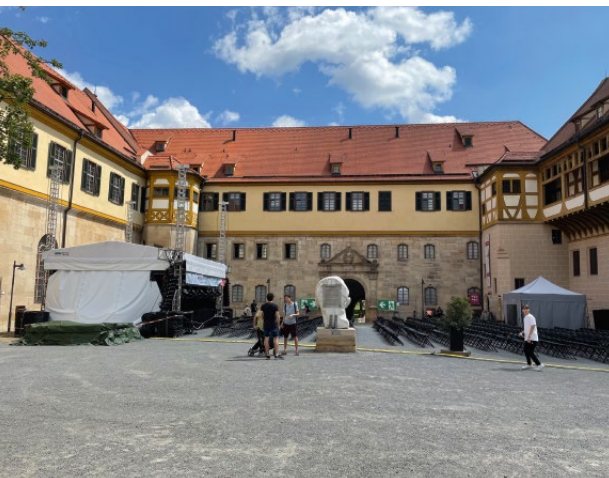
Abb.1: Bühnenaufbau aus Sicht des Lichtschachtes, dem ehemaligen Hangplatz © I.Kaipf
