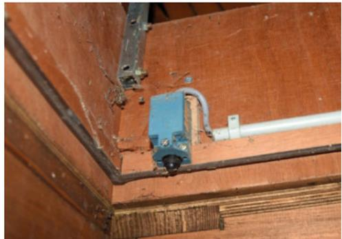
Der Trennschalter an der Dachbodenklappe koppelt bei geschlossenem Zugang die Stromversorgung ab und das Licht im Dach geht aus (Foto: Christian Dietz)
