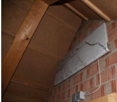
Für sehr kleine Kolonien mit ungünstigen Hangplätzen kann der Einbau einer Wärmebox mit thermostat geregelter Flächenheizung (Natursteinheizung) hilfreich sein (Foto: Christian Dietz)
