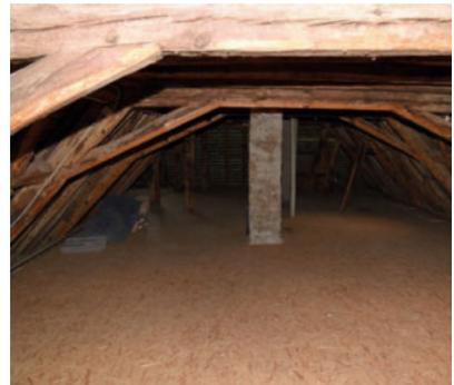
Ein neuer Bodenbelag mit OSB-Platten zur leichteren Reinigung des Quartierbereiches kann zusammen mit der Isolation der darunter liegenden Geschosdecke verlegt werden und sorgt für eine gute Trennung zwischen Wohn- und Quartierbereich (Foto: Christian Dietz)
