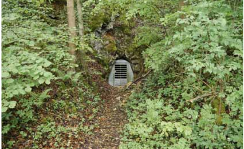
Abb. 2: Blick auf den vergitterten Eingang des Hessenloches.
