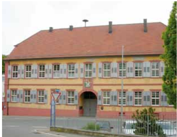
Saniertes Schloss in Tairnbach. Foto: B. Heinz.
