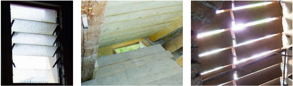
Abb. 2: Links: Lamellen in einem Glasfenster. Mitte: Sich nach unten hin öffnender Einflug im Dachüberstand. Rechts: Schalläden aus Holz mit einer Vergitterung im unteren Bereich.
