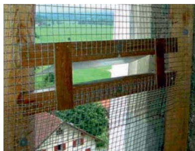
Abb. 1: Links: Einflugmöglichkeit nach dem Umbiegen des Gitters. Der umgebogene Teil sollte dicht an dem dahinter befindlichen Gitter anliegen, damit sich die Tiere nicht im Spalt verfangen können (Maßangaben in mm). Mitte: Rollstangen. Foto: Keil Rechts: Öffnung im Gitter eines Turmfensters mit Anflugbrett. Spalt 10-15 cm breit. Ein schräges Blech oberhalb der Öffnung verhindert die Landung von Tauben. Foto: G. Knipfer
