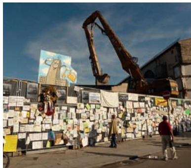
Abriss Nordflügel Stuttgarter Bahnhof
