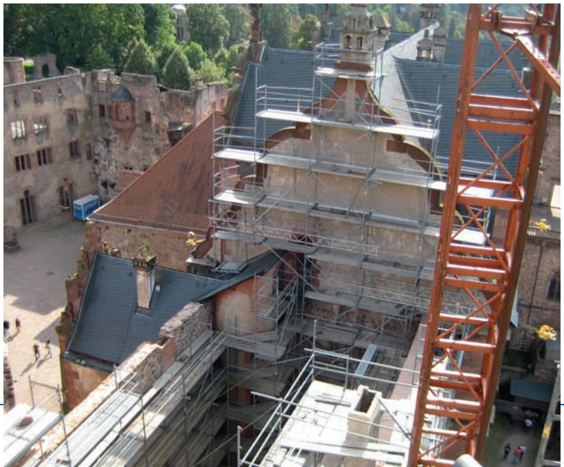
Gläserner Saalbau mit Baugerüst in der Schlossanlage Heidelberg. Foto: B. Heinz
