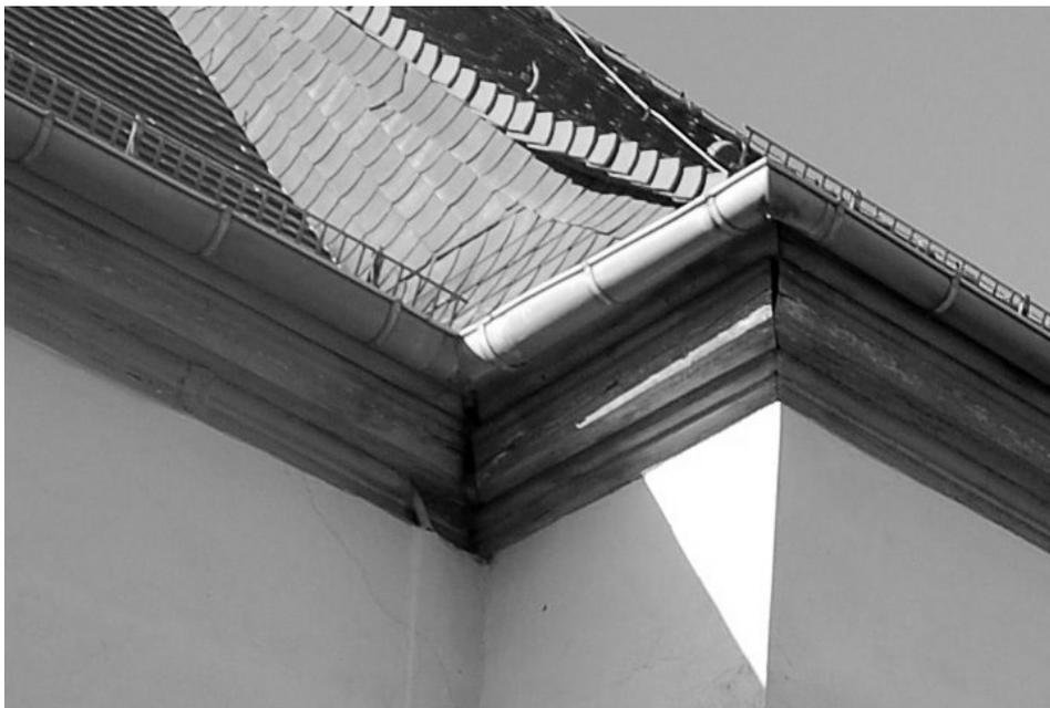
Abbildung 7: Ein durch bauliche Mängel entstandener Spalt wird von Fledermäusen als Einschlußöffnung genutzt. - Foto: V. Dorka.
