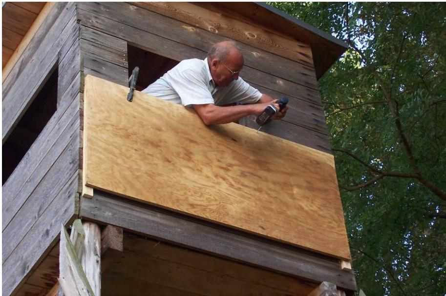
Abbildung 8: Eine Jagdkanzel erhält durch Hans-Gerd Tschuch eine doppelte Wand, so dass ein Spaltenquartier für (Mücken-) Fledermäuse entsteht. – Foto: A. Arnold.
