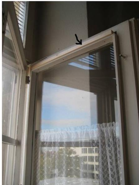
Abb. 3: Das Anbringen einer Holzleiste verhindert, dass die Doppelglasfenster zur Fledermausfalle werden.
